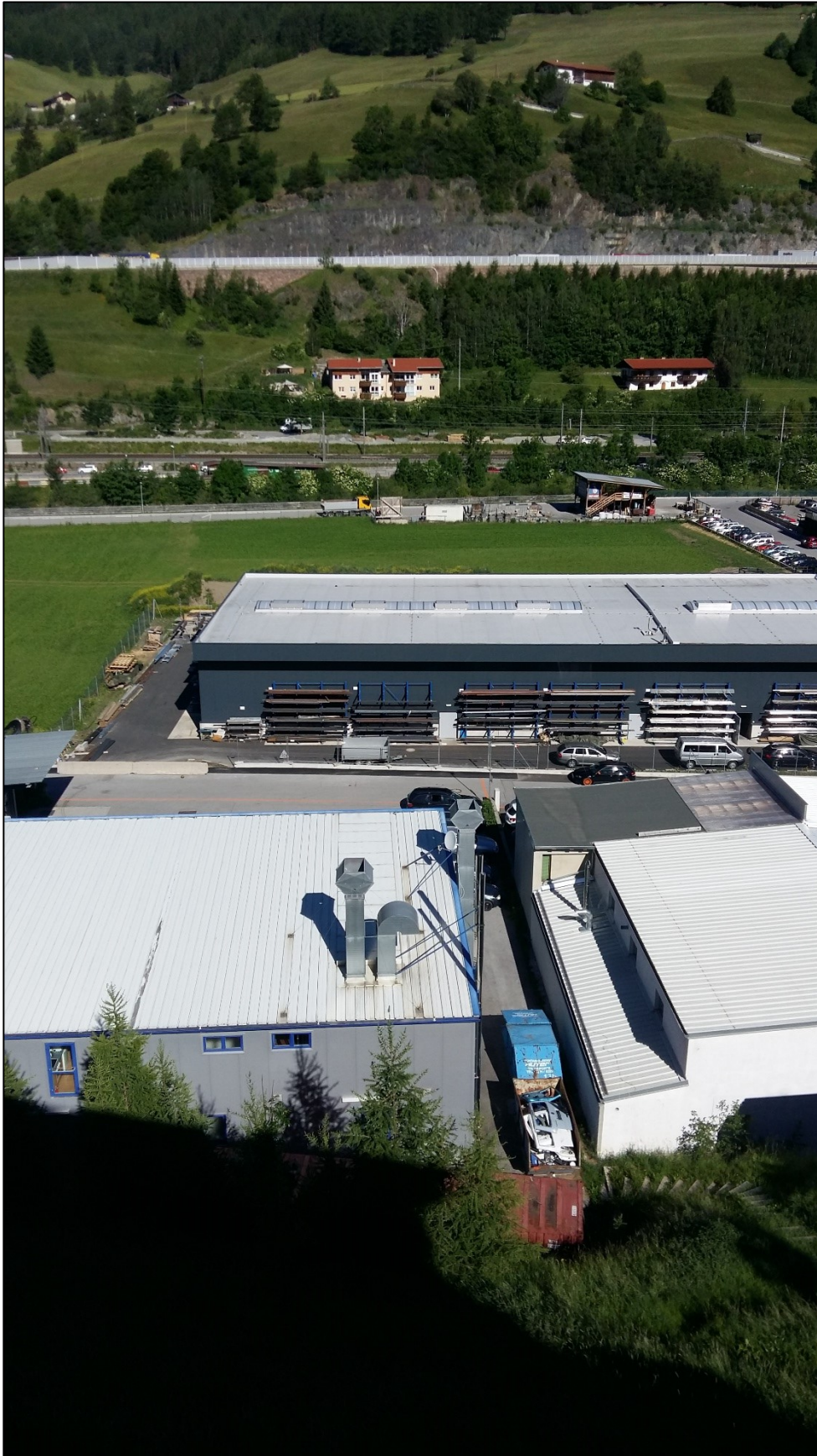
Foto 3: Blick Richtung Nord-West (Wipptal aufwärts verläuft nach links)
