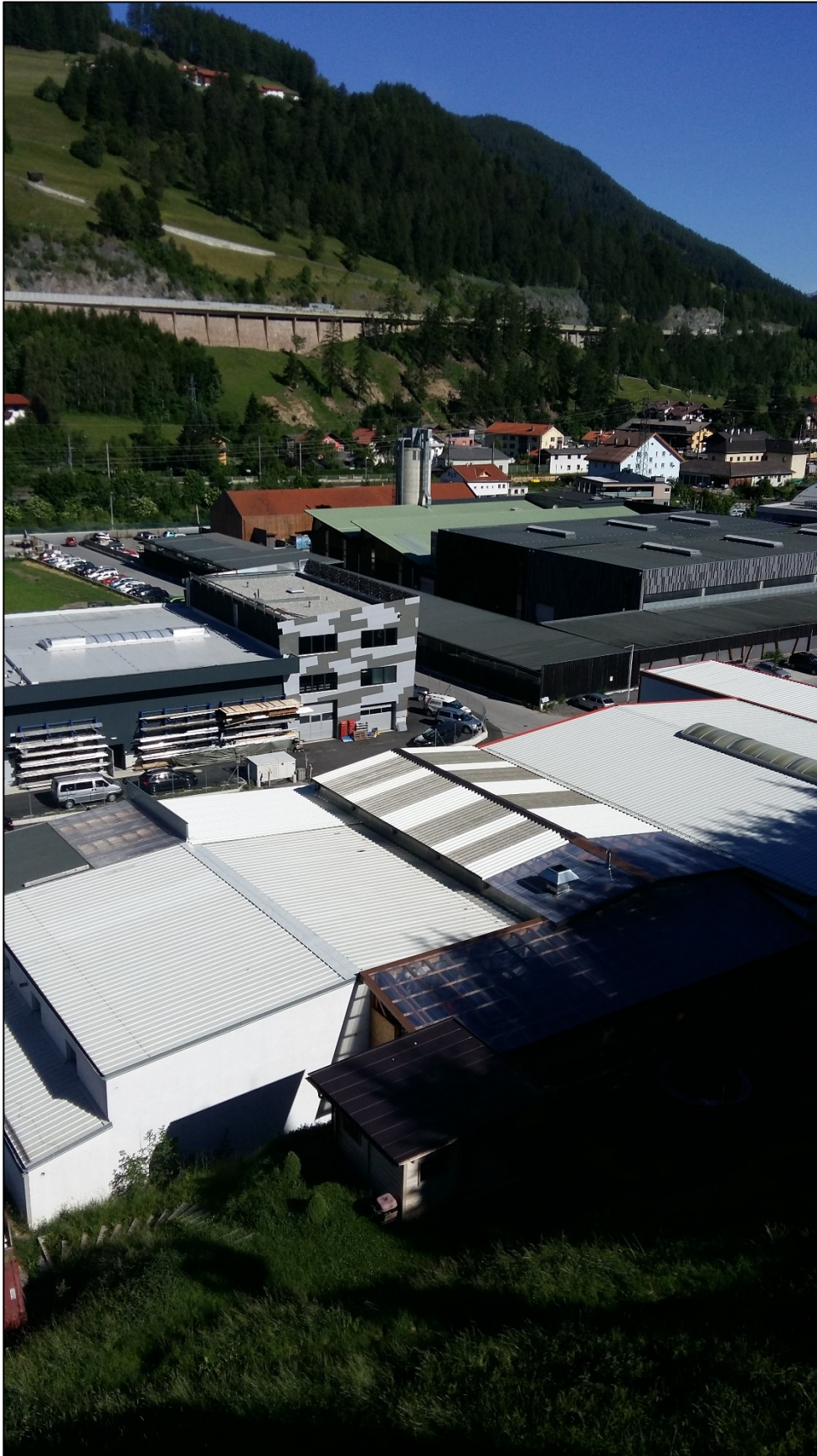
Foto 4: Blick Richtung Nord-West (Wipptal abwärts verläuft nach rechts)
